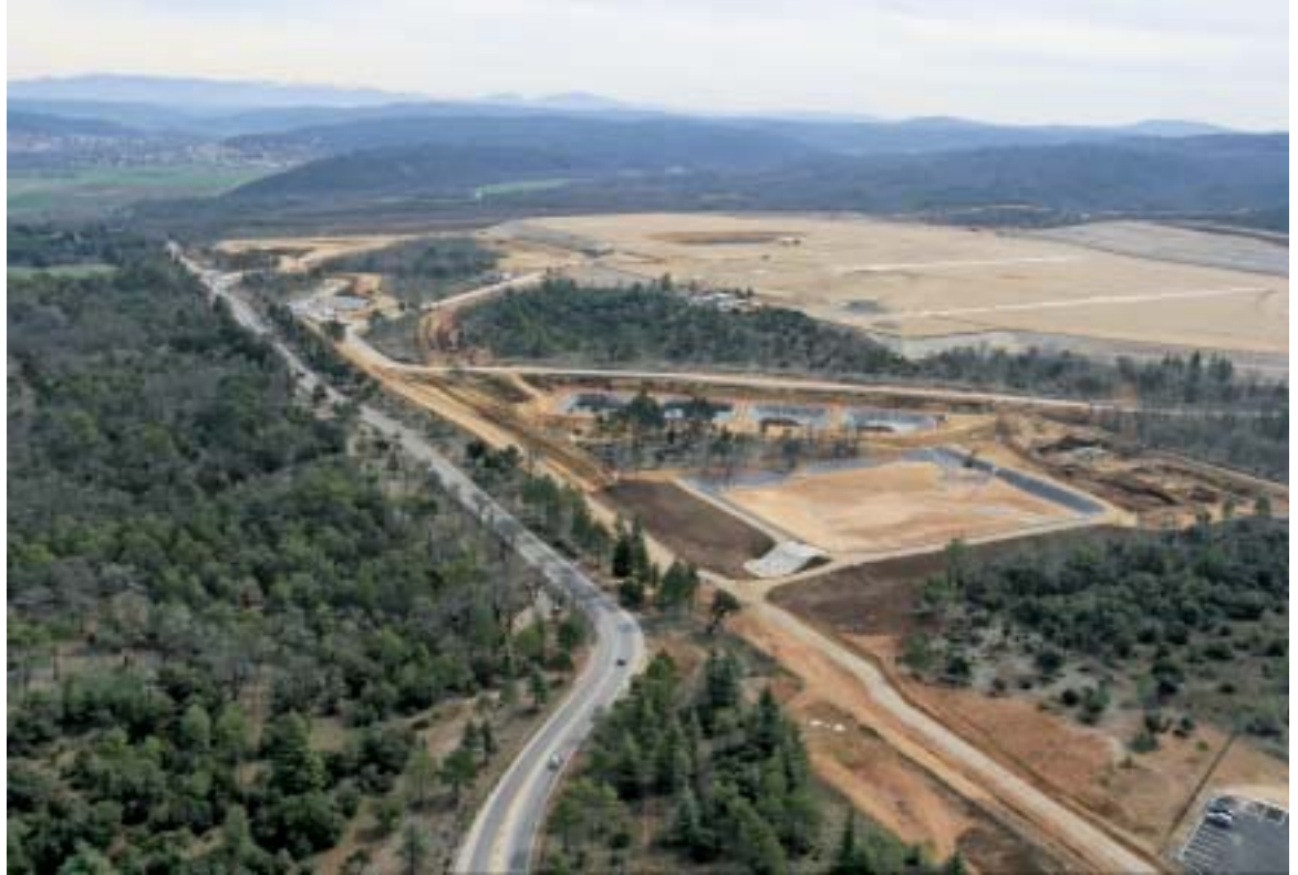
Cadarache: de bouwplaats van de internationale tokamak ITER
