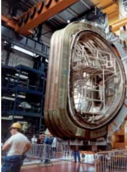
De bouw van het D-vormige reactievat van tokamak JET
